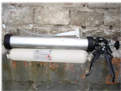
Aplikace pomocí vytlačovací pistole
