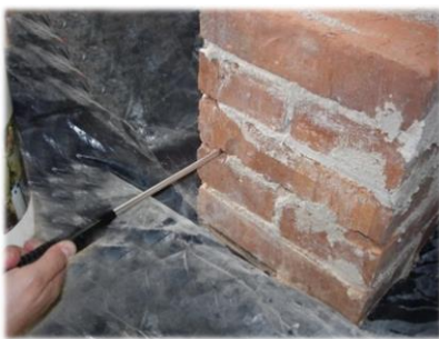
Aplikace pomocí nízkotlakového postřikovače (pumpy)
